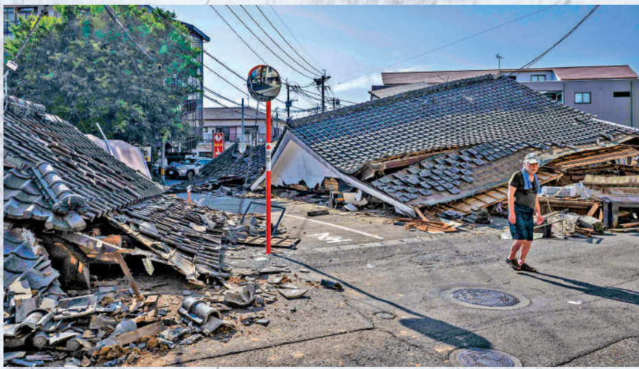
▲八代市多棟房屋在地震中倒塌。
