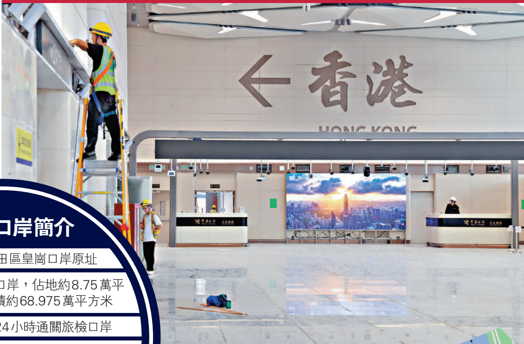
▲工人在皇崗口岸聯檢大樓內施工，為通關做好準備。新華社
