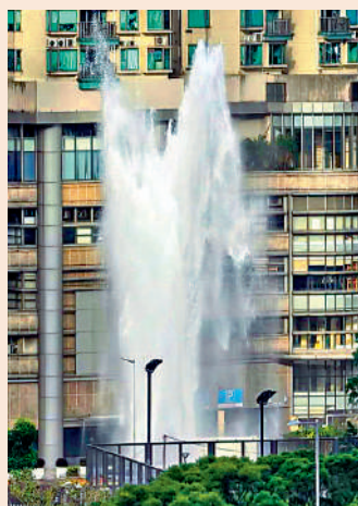
▲大角咀海帆道行人路昨晨有鹹水管爆裂，射出一條高達十多米的水柱。
