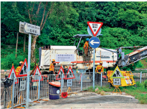
▲緊急搶修過程中需開掘與回填，可能將壓力轉移至鄰近較脆弱的喉管，引致新漏點。
