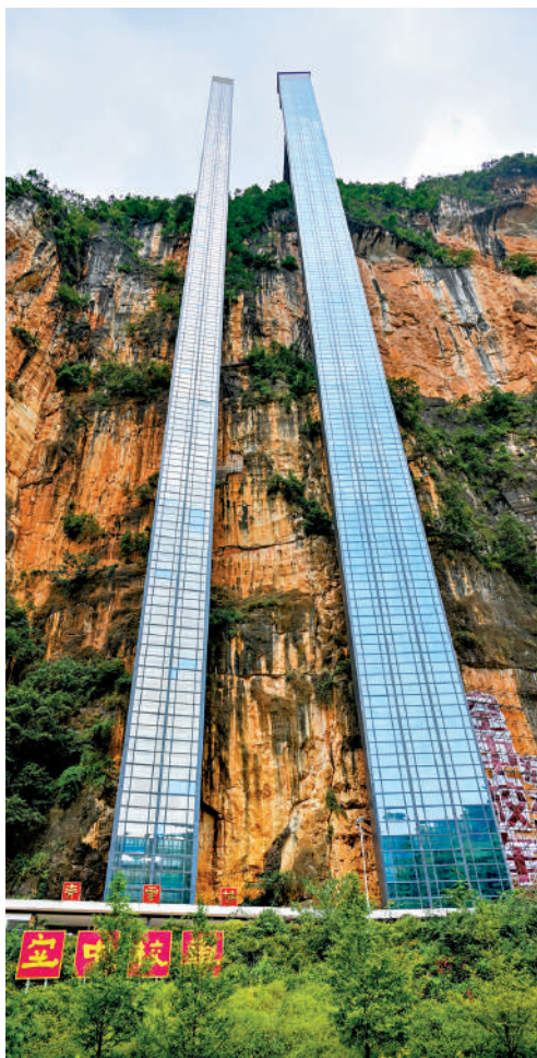
▲近日，雲南省曲靖市宣威市尼珠河大峽谷二號「空中校車」（右）正式啓用。該電梯與2022年投用的一號「空中校車」聯動運行後，每小時總運力提升至1200人次。中新社
