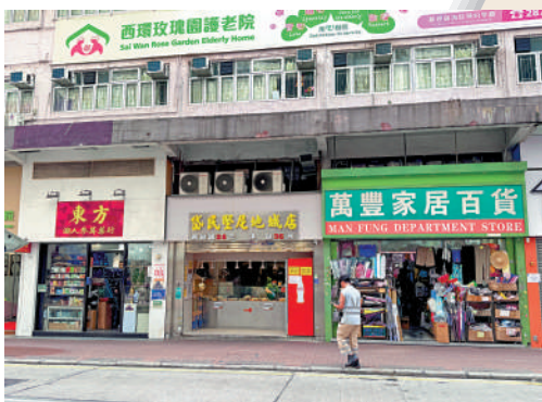
▲在堅尼地城卑路乍街，有護老院地下入口處亦沒展示門牌。
