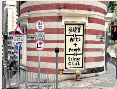
▲依附在中環藝穗會外牆的「雲咸街」及「下亞厘畢道」路牌，是碩果僅存的由瓷磚加水泥製造的第一代T型路牌。
