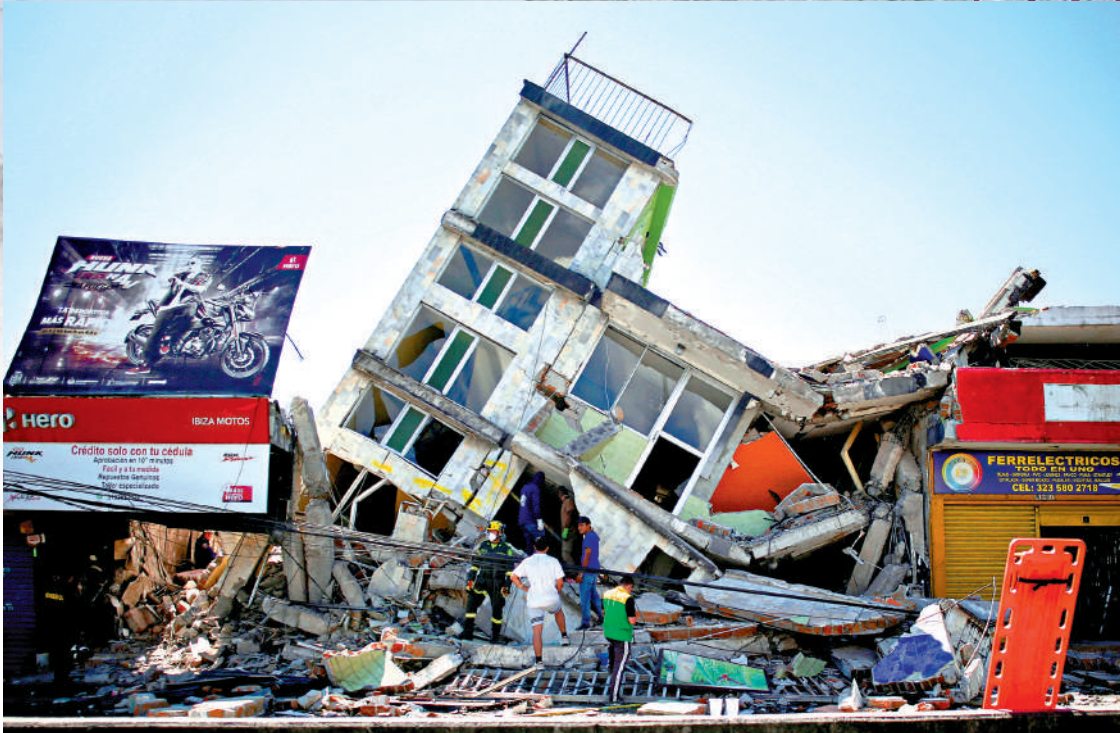
▲哥倫比亞10日發生強震，喬科省多斯克布拉達斯市一棟建築物倒塌。
