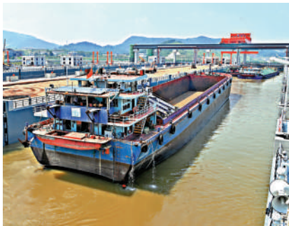
▲試驗船舶駛進馬道樞紐船閘，檢驗通航能力。
