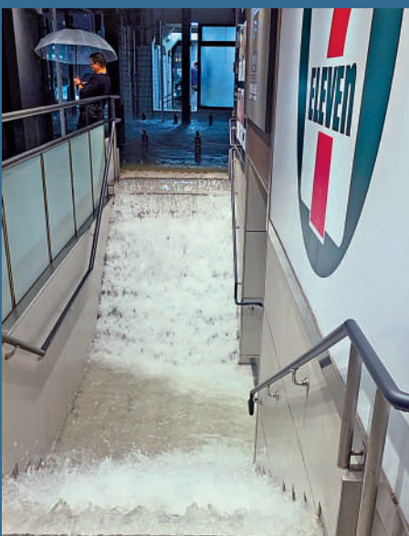
▲千葉佩里購物中心的樓梯13日發生雨水倒灌，宛如瀑布。
