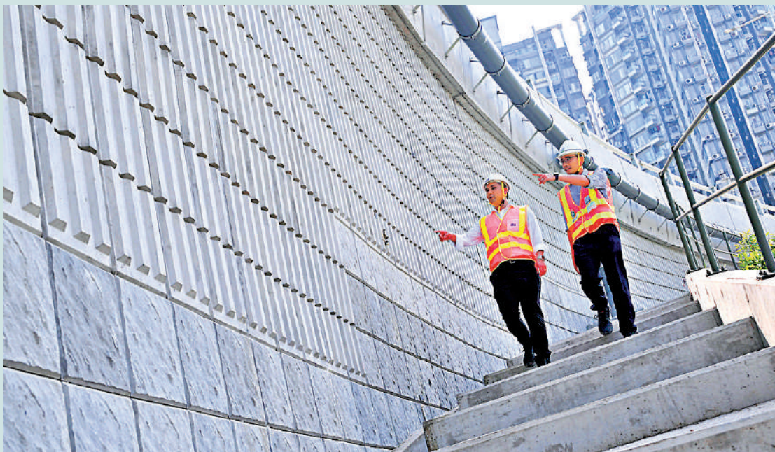
▲建科院早前促成一款本地研發的高延性輕質複合混凝土「落地」，在元朗一個路堤工程使用。
