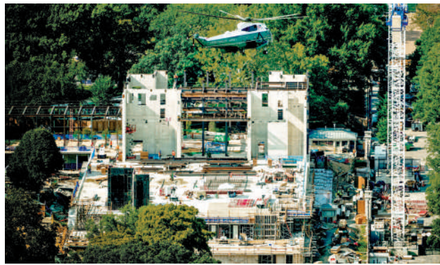
▲白宮新建宴會廳的施工區域。美聯社
