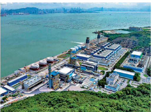
▲中華電力在龍鼓灘發電廠開展氫氣混合天然氣發電試驗項目。中電圖片
