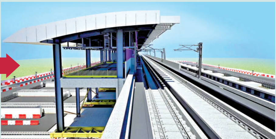
▲最後兩米進行最後一次平移關鍵接駁，隨後鋪設架空電纜及改造鐵路設施，確保與現有屯馬綫系統無縫連接。港鐵視頻截圖
