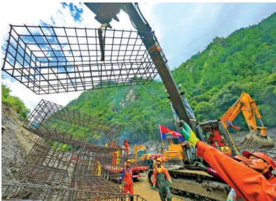
◀在道路搶通現場，鐵籠並填滿石塊等填充物，工人阻擋異物沖擊路面。新華社
