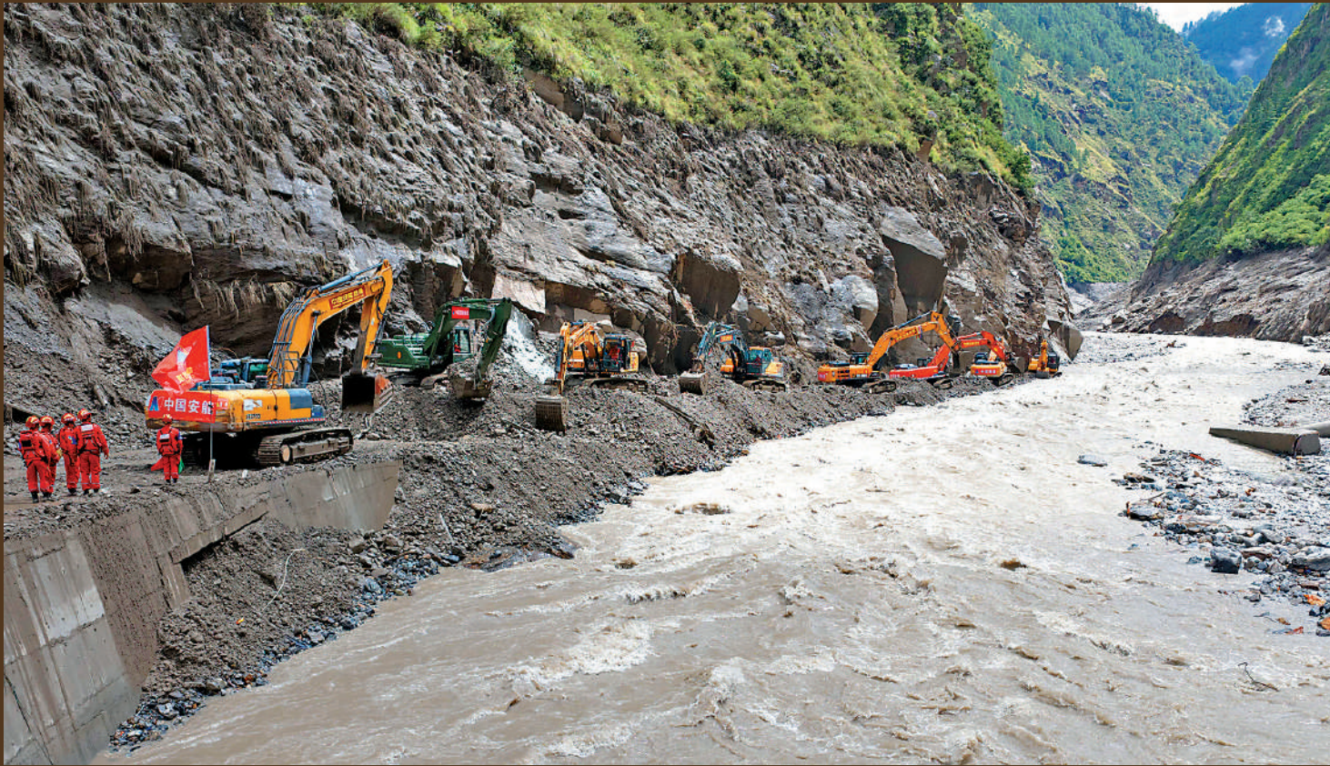
▲8月29日，應急管理部調派中國安能工程力量持續開展道路搶通作業，投入70名技術和技能骨幹，調集挖掘機、裝載機等14台套工程救援裝備，對G216國道損毀路段全力開展搶通作業。
