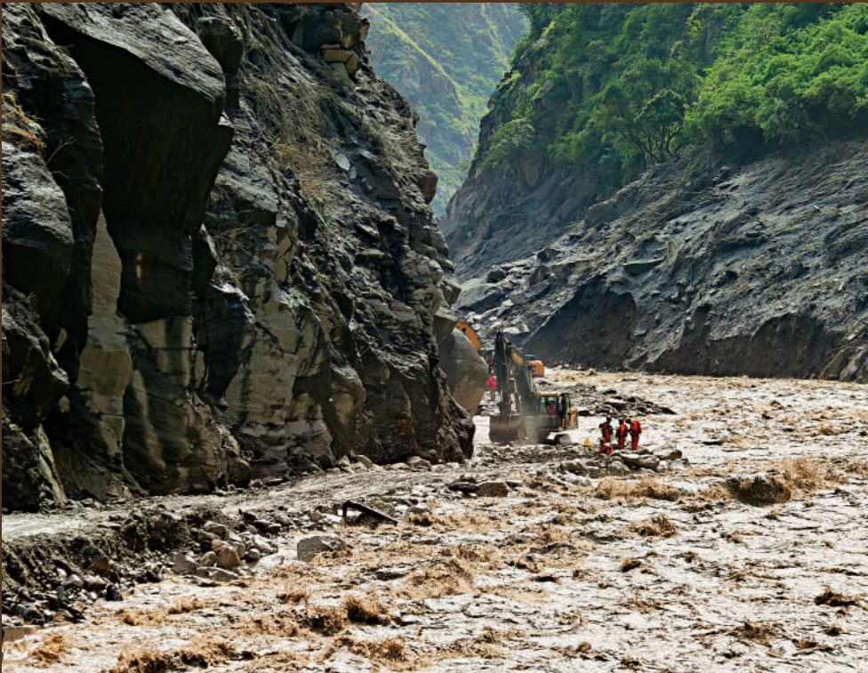
▲8月30日，救援人員在重型機械協助下，於吉隆泥石流災害現場開展救援工作。新華社 ►搶通損毀的G216國道成為西藏泥石流災害救援搶險工作重點之一。工作人員從車上卸下的鐵籠將被裝入石塊等填充物，放置在沖毀道路沿線。新華社
