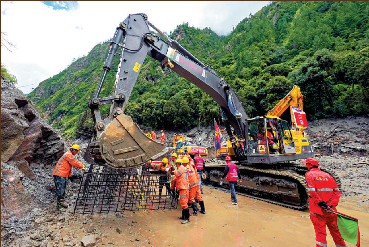
▲8月30日，救援人員在重型機械協助下，於吉隆泥石流災害現場開展救援工作。新華社 ►搶通損毀的G216國道成為西藏泥石流災害救援搶險工作重點之一。工作人員從車上卸下的鐵籠將被裝入石塊等填充物，放置在沖毀道路沿線。新華社
