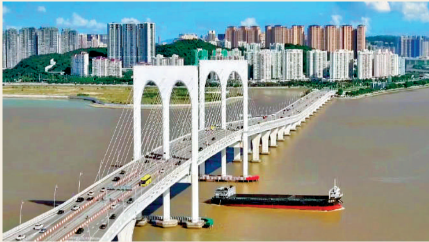
▲澳門西灣大橋。
