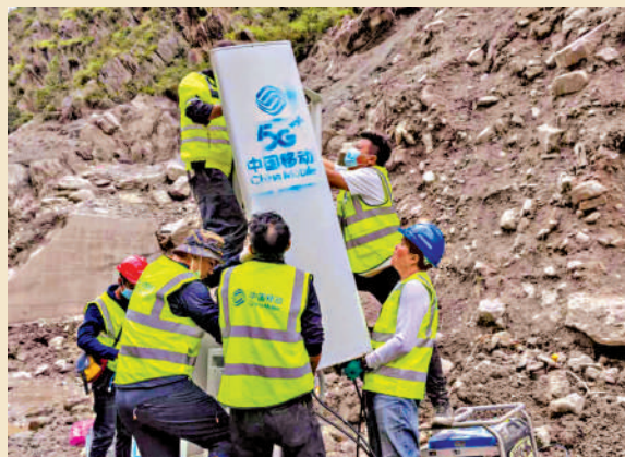
▲西藏自治區應急通信保障人員在救災一線架設4G/5G基站。 新華社
