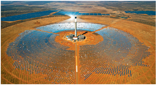
▲由中國承建的南非紅石100兆瓦塔式熔鹽光熱電站項目，是南非最大可再生能源投資項目之一。
