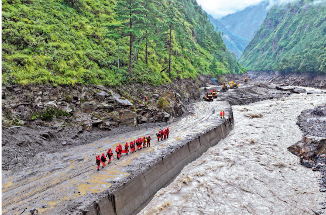
▲8月26日，因尼泊爾一側發生泥石流災害，造成西藏吉隆口岸重大人員傷亡、失聯。救援人員連日來動用重型機械，加緊搶通吉隆口岸交通要道。
