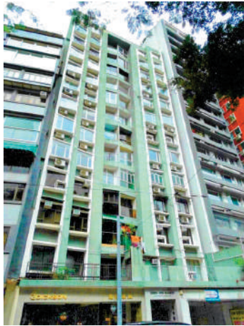
◀翠景樓現時建築結構狀況良好，被駁回強拍申請。
