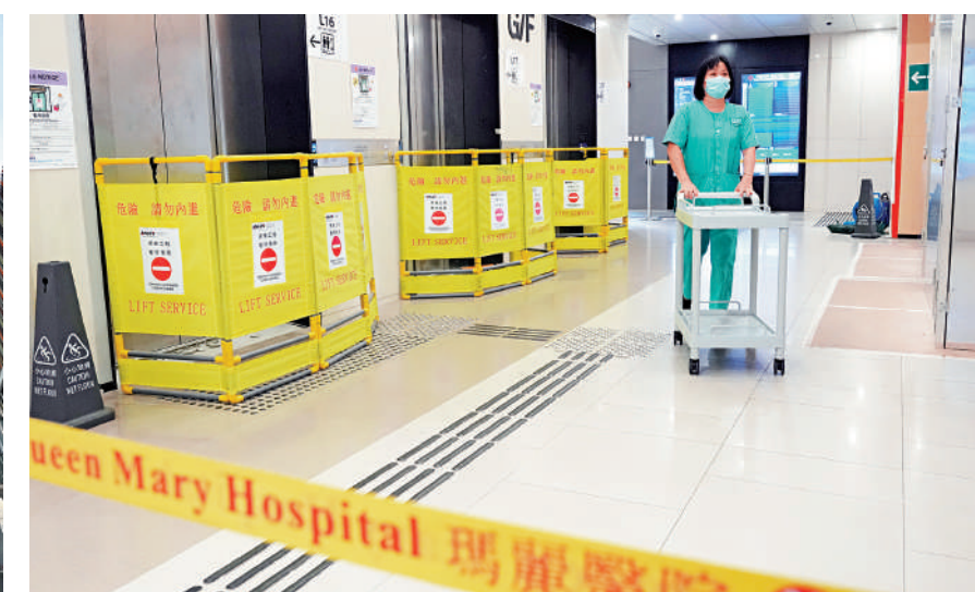
▲瑪麗醫院新臨床大樓早前被揭二十八部升降機中有二十四部出現故障，引起社會關注。 大公報記者林良堅攝
