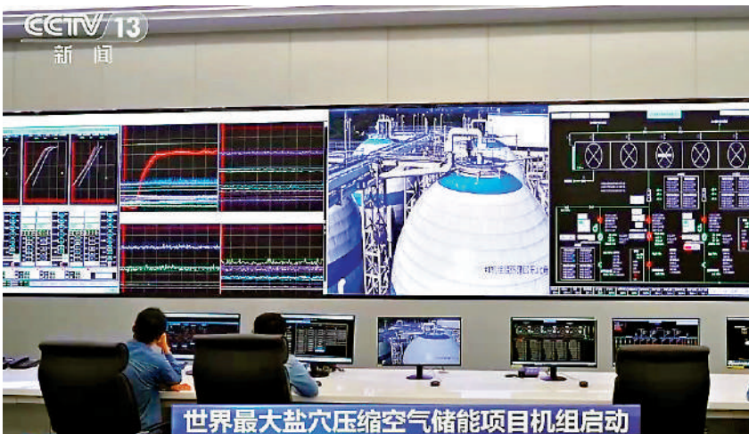
▲工作人員在集控室監測儲能電站運行。央視截圖
