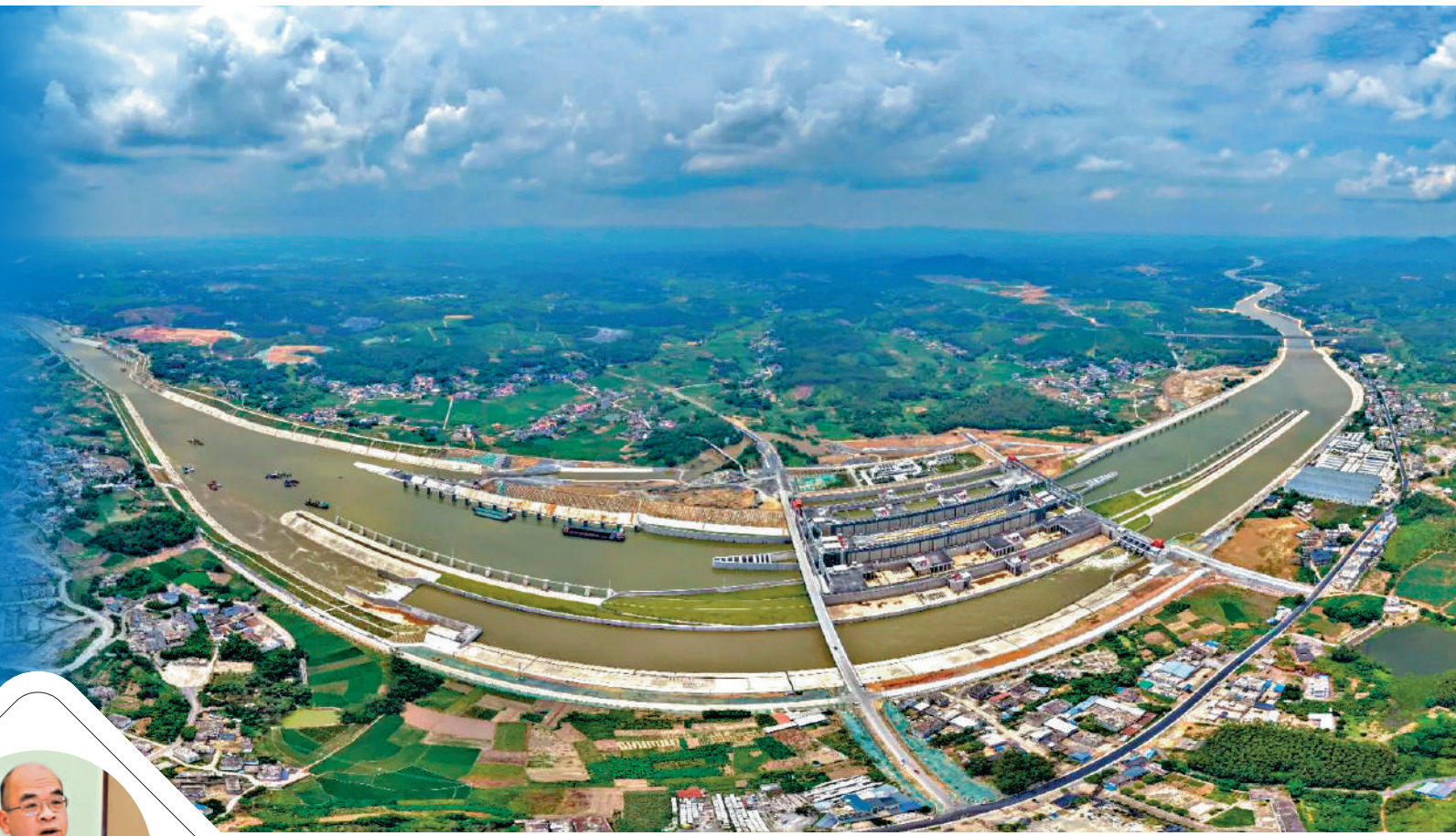
▲新中國成立以來第一條國家層面統籌建設的通江達海運河工程——平陸運河昨日建成通航，開闢西南出海新通道。圖為企石樞紐全景。平陸運河集團供圖
