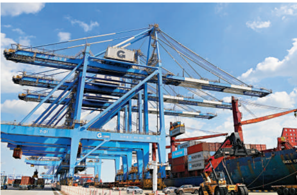
▲開放合作，互利共贏，平陸運河為中國高水平開放合作注入新動能。圖為北部灣港欽州自動化集裝箱碼頭。新華社
