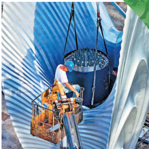
▲主火炬塔內部進行安裝。受訪者供圖
