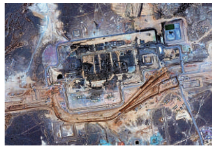
▲衛星圖像顯示，沙特東西輸油管道正開展維修作業以及繞行管線的施工。
