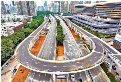
▲本次完成竣工驗收的皇崗路節點建設包含新建橋樑匝道、新建地面輔路、新建地下隧道等。
