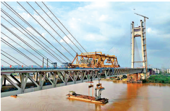
▲深江高鐵「洪奇瀝公鐵大橋」近日合龍。受訪者供圖
