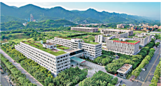
▲海扶科技發力前沿腦科學領域。圖為重慶海扶科技產業園。 受訪者供圖
