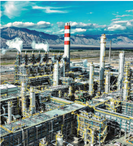
▲中國石油獨山子石化塔里木120萬噸乙烯工程核心裝置——乙炔裝置。受訪者供图
