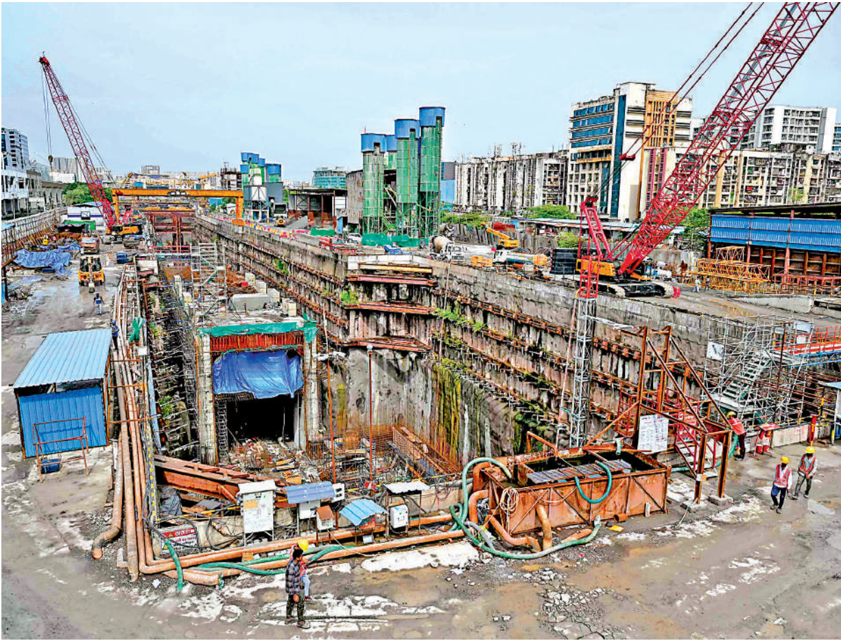
▲2026年6月25日，印度孟買的首條高鐵工地現場。
