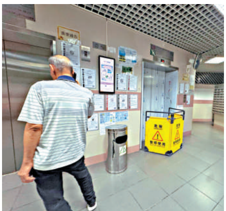
▲翠屏北邨翠楊樓升降機早前被檢測出安裝工程未完成。大公報記者曾敏捷攝
