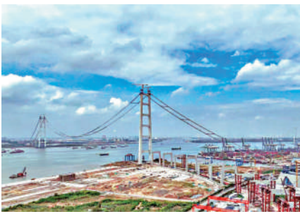
▲獅子洋大橋正進行貓道架設施工。受訪者供圖
