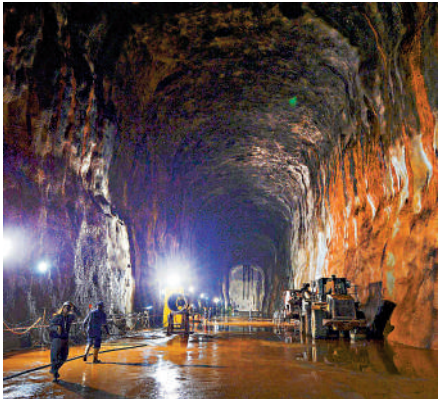
▲沙特計劃2027年下半年起，在新加坡裕廊岩洞儲存原油。圖為裕廊岩洞內早前在施工。
