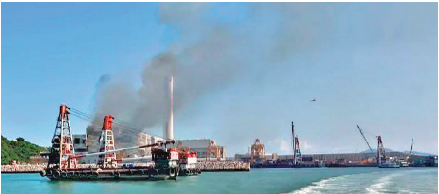
▲綜合廢物處理設施第一期前日發生三級火警，焚燒四小時。資料圖片
