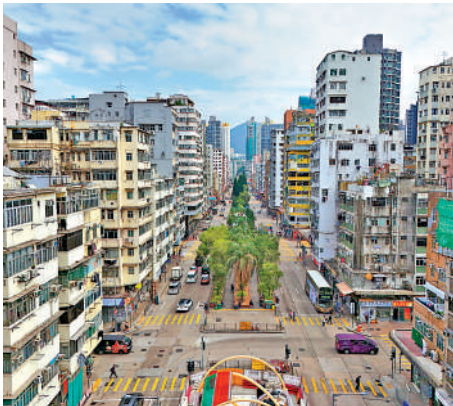
▲政府正檢討市建局「同區七年樓齡」賠償政策及「樓換樓」安排，明年上半年展開諮詢。大公報記者攝
