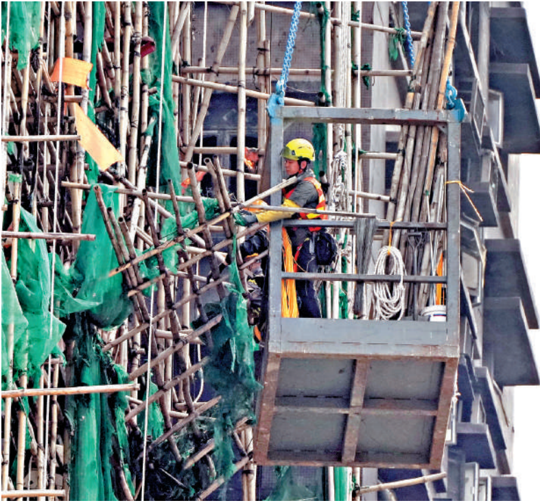
▲房屋局會改革架構，於下月成立「公營房屋樓宇管制組」，取代目前的獨立審查組（ICU）。圖為宏福苑大火後，工人拆除餘下的棚架。資料圖片
