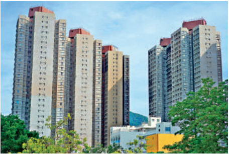
▲大埔宏福苑一場火警，掀開本港舊樓維修監管諸多問題。資料圖片
