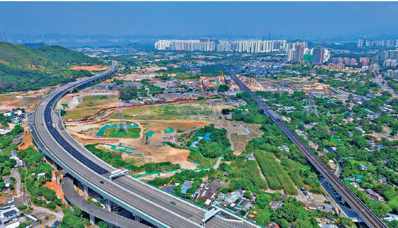
▲洪水橋大學城用地加速平整及基礎建設工程，預計在今年內可陸續產出校園區用地。
