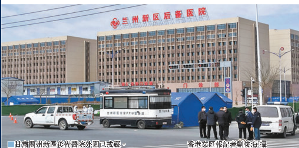
甘肅蘭州新區後備醫院外圍已戒嚴。
