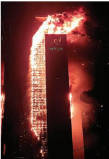
■33層樓高的商住大樓起火後，火勢沿外牆一直燒到頂樓。
