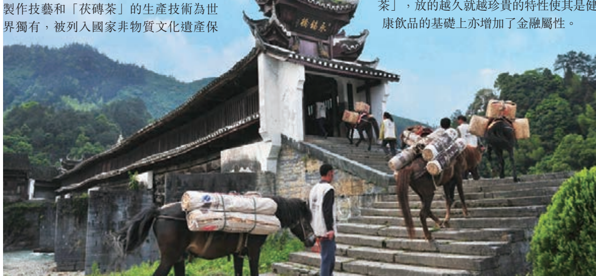
圖為位於湖南省益陽市安化縣境內的風雨廊橋永錫橋,該橋是原茶馬古道運茶的必經之橋。
