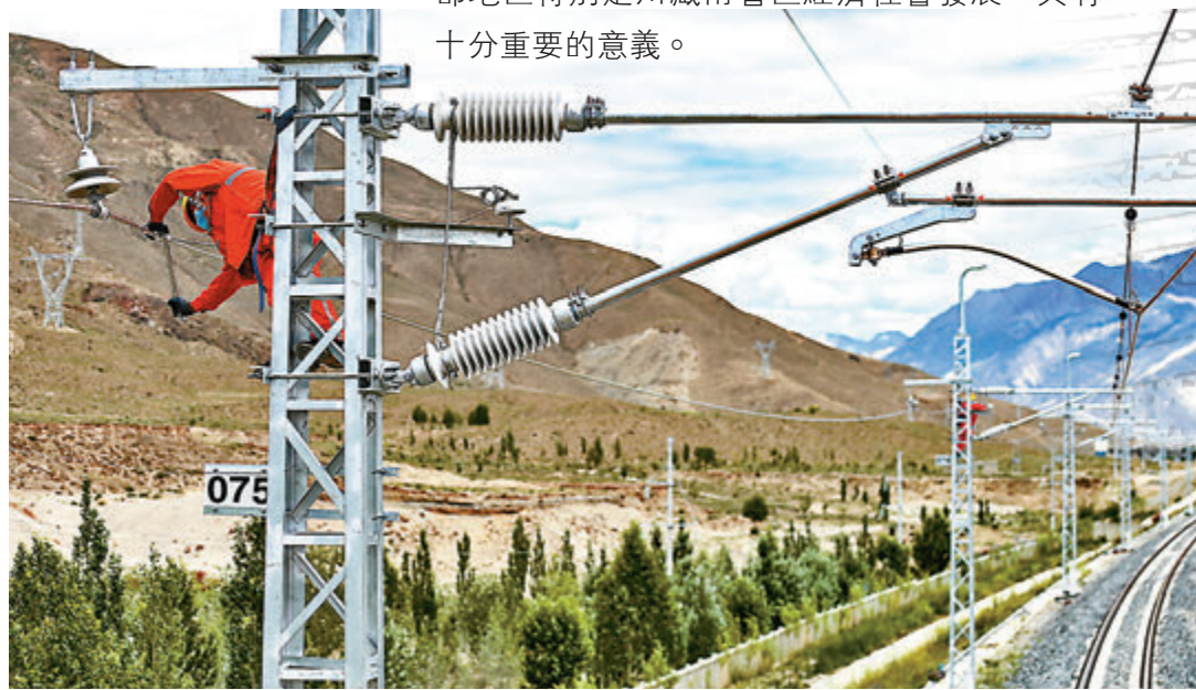
■拉薩至林芝段於2015年6月開工建設,目前進展順利。圖為7月,中鐵電氣化局施工人員對拉林鐵路接觸網專業首件工程進行覆檢。資料圖片
