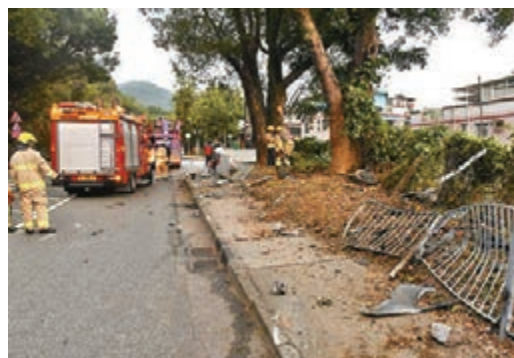
現場路邊一排鐵欄被撞毀。
