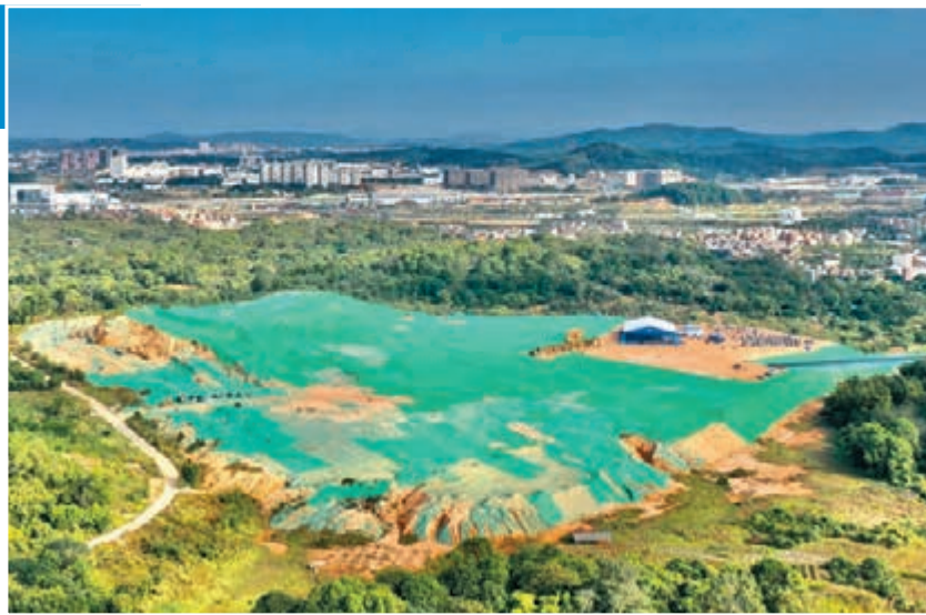
■中新廣州知識城集成電路產業園南片區動工。受訪者供圖
