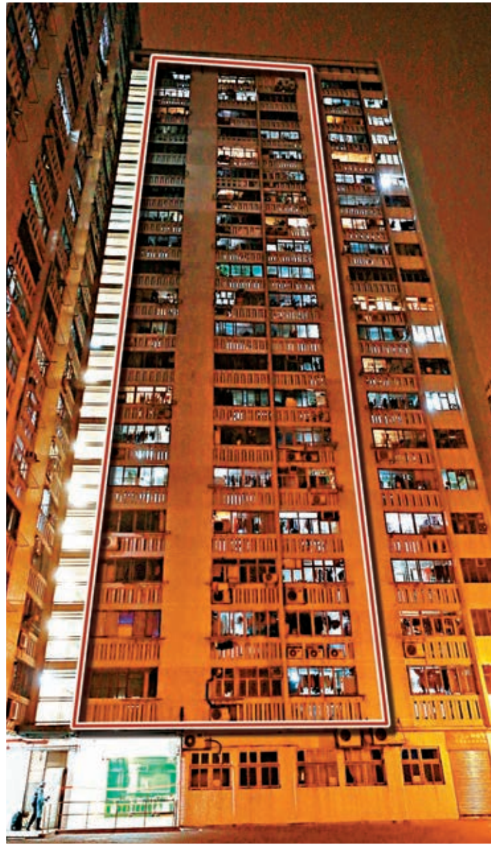
■彩雲邨明麗樓1樓至22樓的33室及34室居民需要全部撤離。 香港文匯報記者 攝
