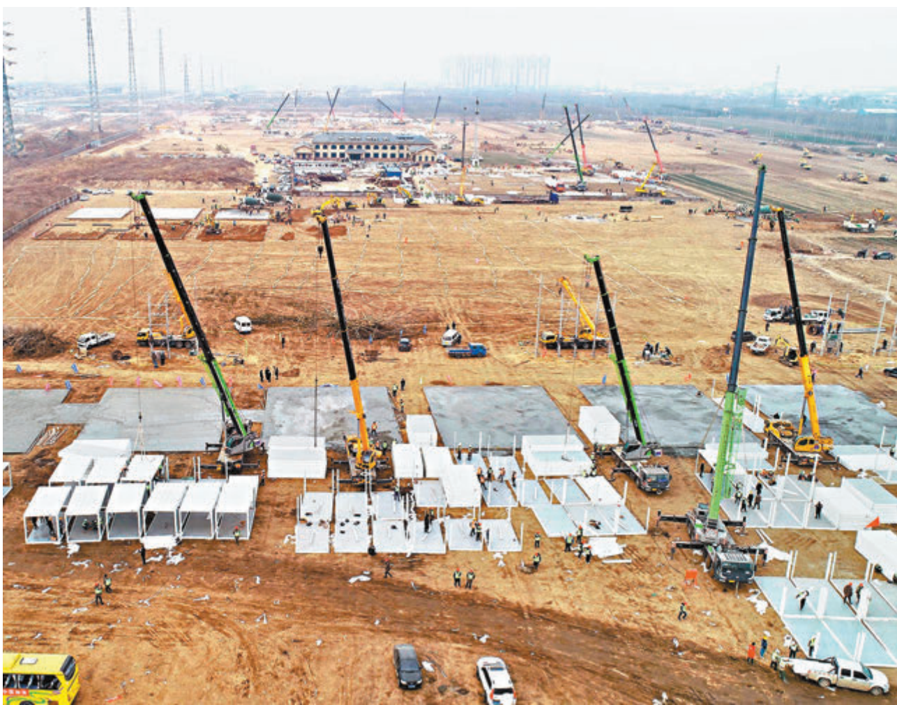
●昨日，石家莊集中隔離點項目加緊施工。
