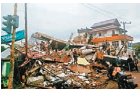
● 印尼地震造成多處房屋坍塌。美聯社
