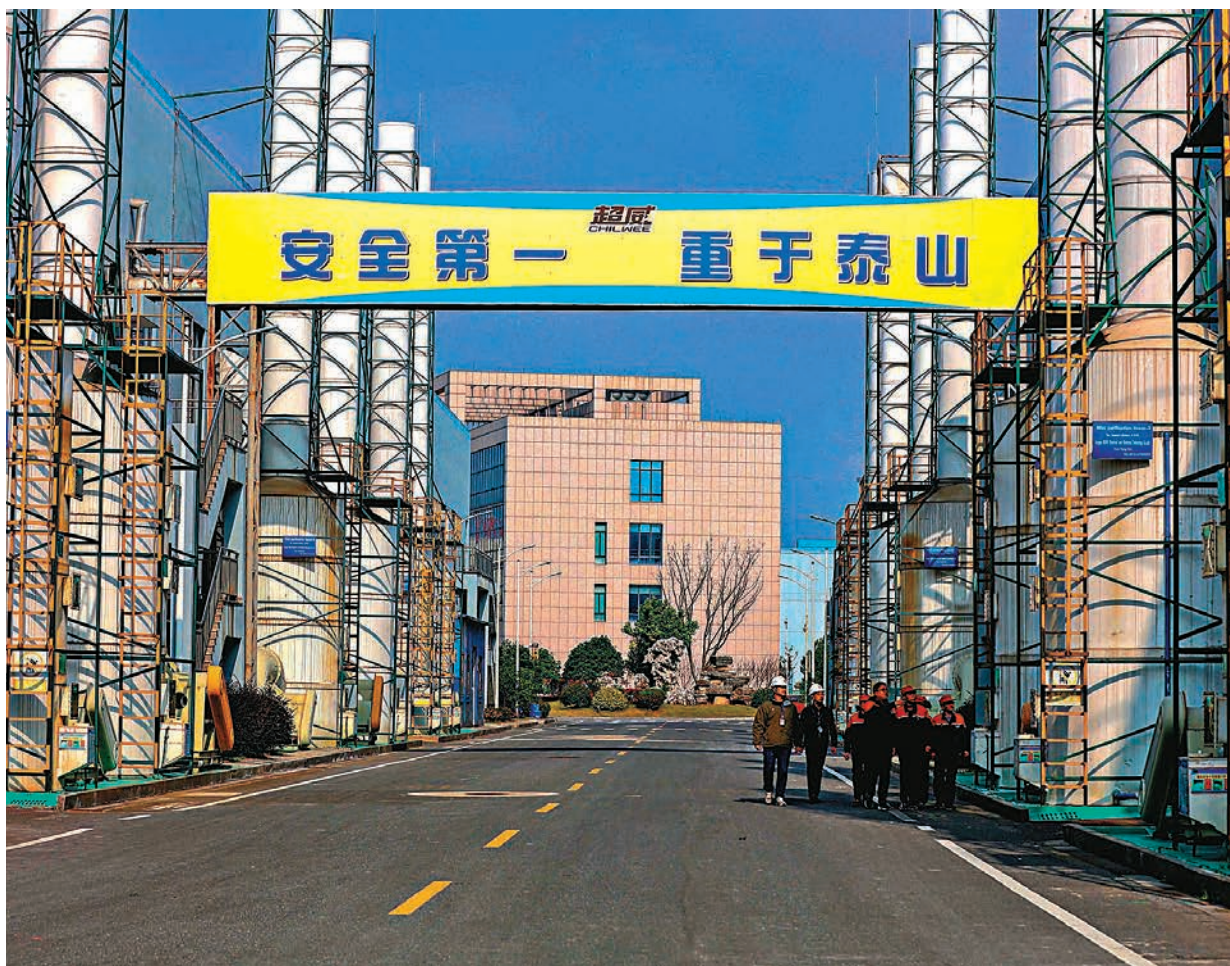
●全國安全生產電視電話會議要求，提升本質安全水平，加強重大安防工程建設。圖為早前浙江省湖州市長興縣小浦鎮應急管理中心工作人員對轄區內企業進行安全生產檢查。
