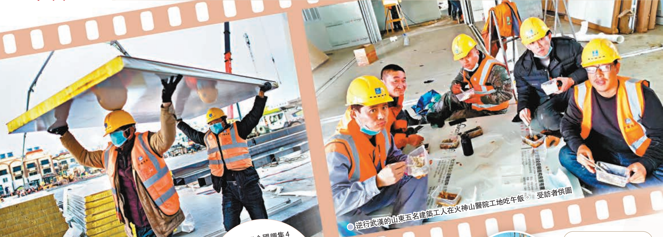
中國從全國調集4萬名建設者和幾千台機械設備支援武漢，僅用10天建成火神山醫院，僅用12天建成雷神山醫院。短短10多天建成16座方艙醫院。圖為2020年1月28日，工人在為火神山醫院趕工。資料圖片
