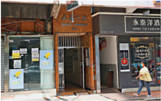
● 居民撤離後的尖沙咀金巴利道美園大廈大門洞開。香港文匯報記者 攝
